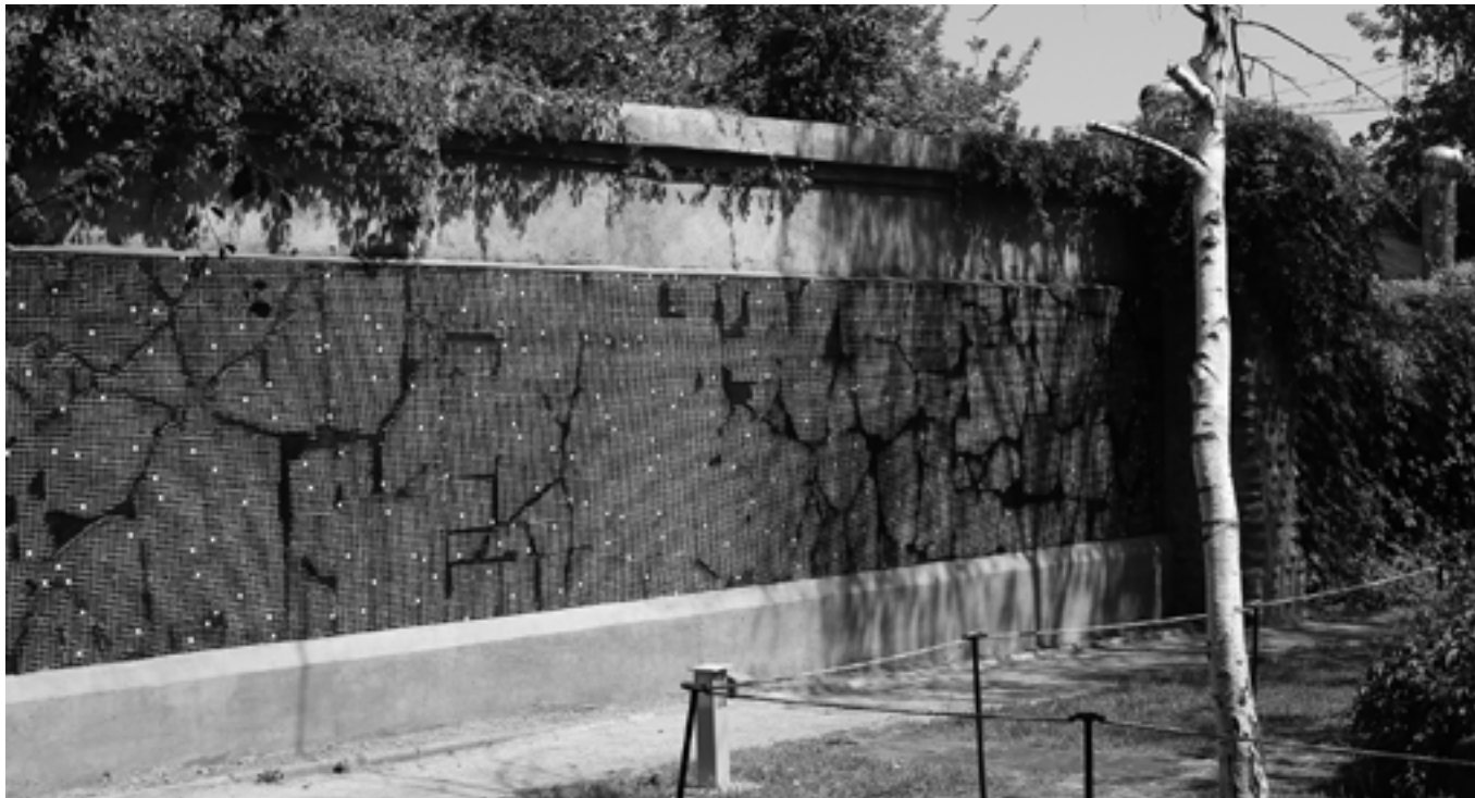
FIGURA 4. Muro de Mosaicos de Villa Grimaldi luego de su restauración (Fotografía: Daniel Rebolledo, 2018).
