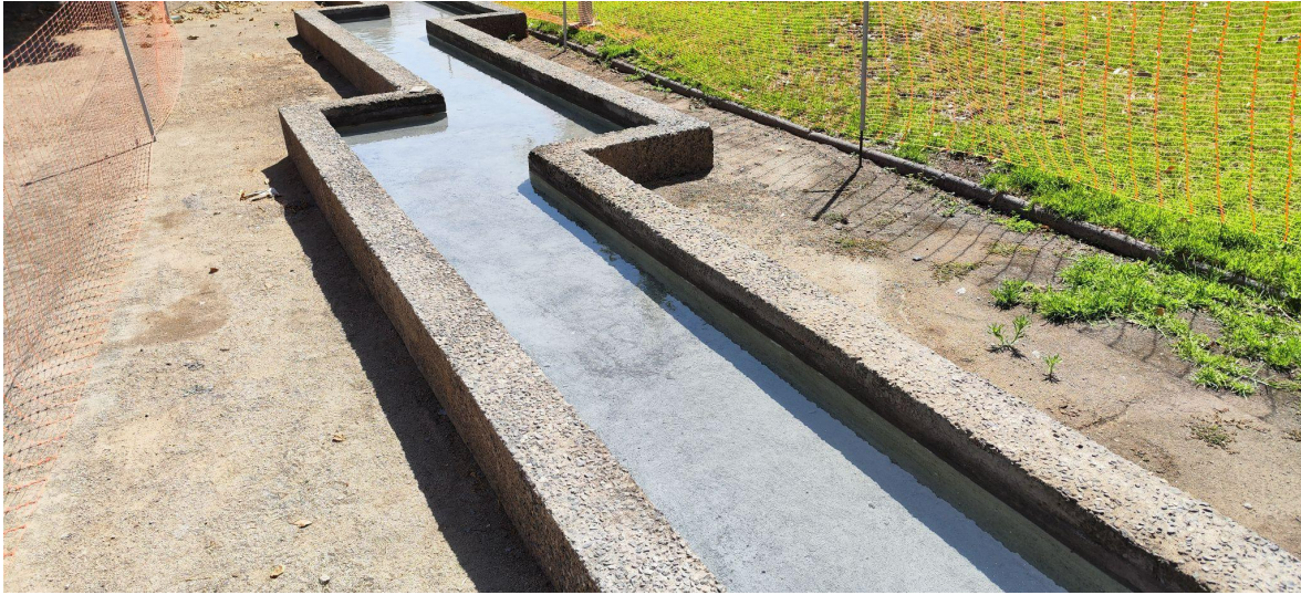
Detalle de los trabajos de impermeabilización
