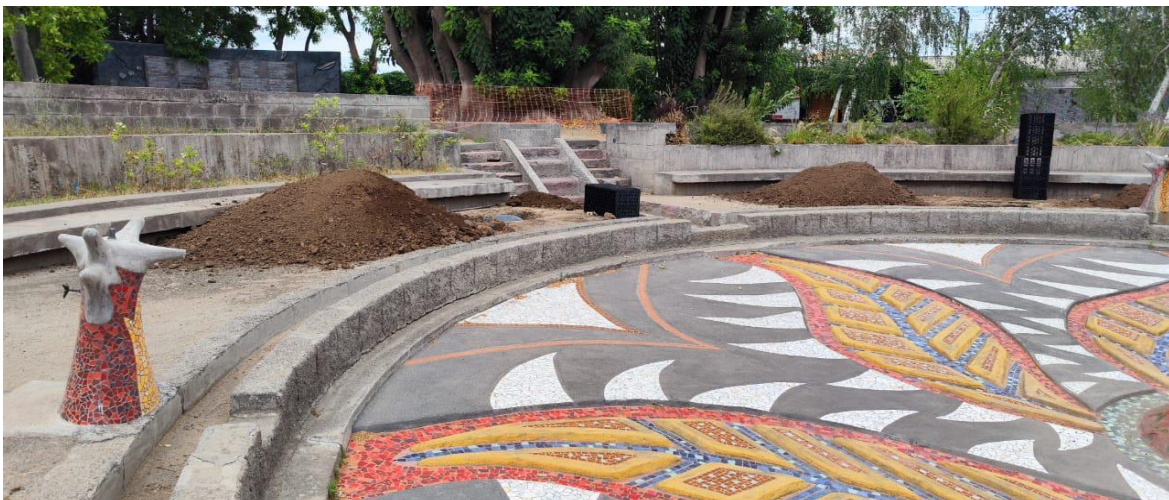
Trabajos en la Plaza de la Esperanza
