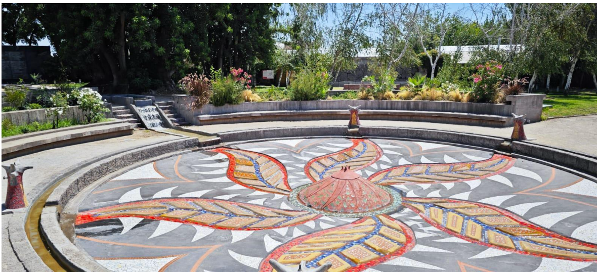
Plaza de la Esperanza con sistema de recirculación de agua funcionando
