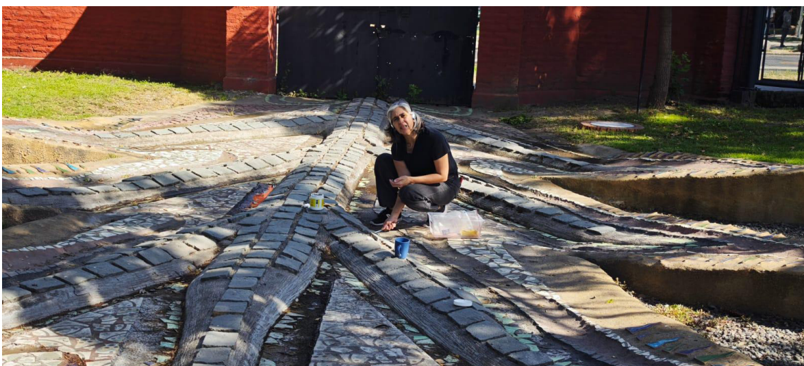
Reparación de teselas desprendidas de la escultura La Llama en el sector del portón de prisioneros
