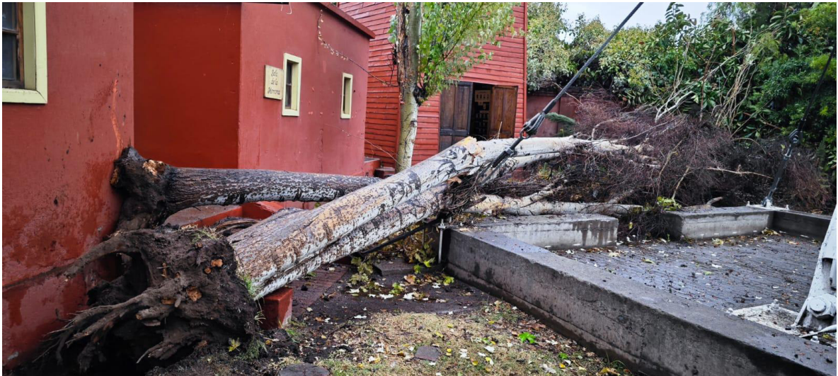
Caída de álamo en el sector de la Sala de la Memoria
