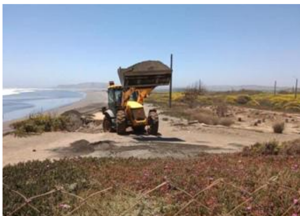
Movimiento de tierra en Sitio de Memoria Ex Centro de Detención y Tortura en Balneario Popular Rocas de Santo Domingo. Fuente: Registros UCMDDHH
