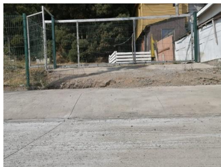
Instalación de calle sin debido acceso a Sitio de Memoria El Morro Fuente: Registro UCMDDHH
