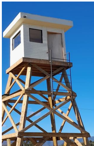
Destrucción caseta vigilancia Sitio de Memoria Melinka Puchuncaví. Fuente: Registros UCMDHH.
