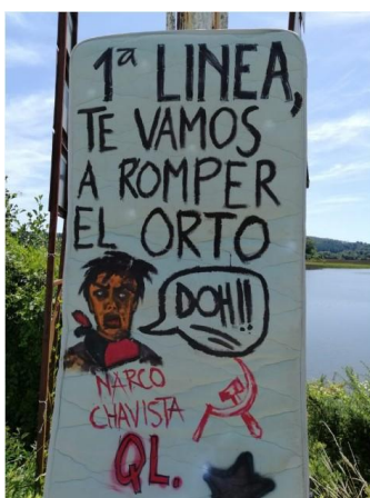
Vandalización Memorial Puente Pichoy.
