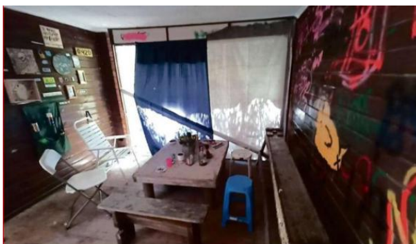
Vandalización en Sitio de Memoria Ex Centro de Detención y Tortura en Balneario Popular Rocas de Santo Domingo. Fuente: Soy San Antonio (21 de octubre de 2021)
