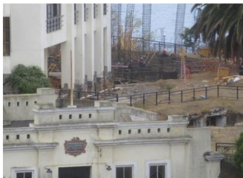
Trabajos en la estructura de Sitio de Memoria Ex Cuartel Silva Palma. Fuente: Sitio Web Marineros Constitucionalistas de Chile (6 de marzo de 2021)
