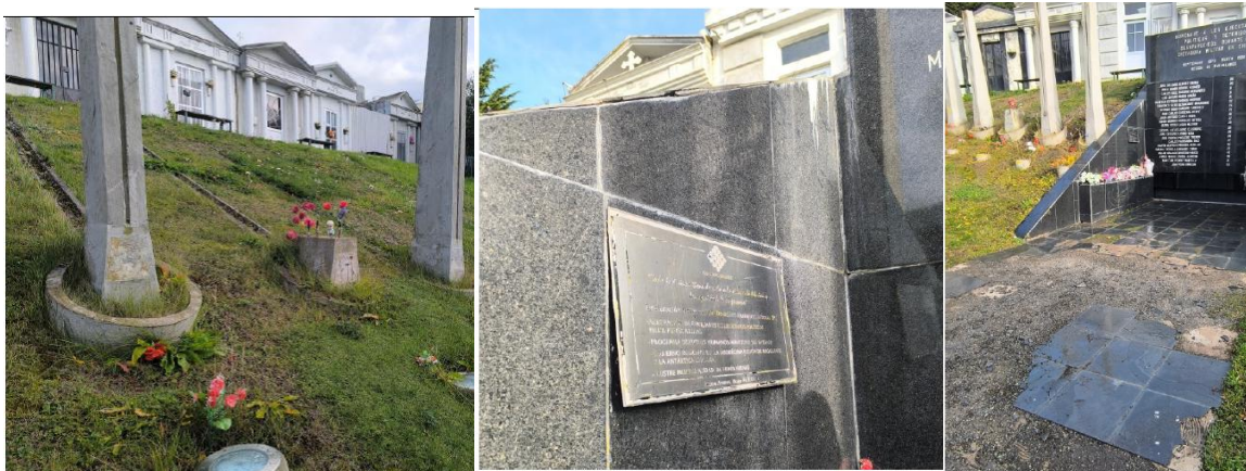
Deterioro y destrucción Memorial Detenidos Desaparecidos y Ejecutados Políticos Cementerio de Punta Arenas Fuente: Ficha de Registro de Alteraciones, CMN. Abril 2026.
