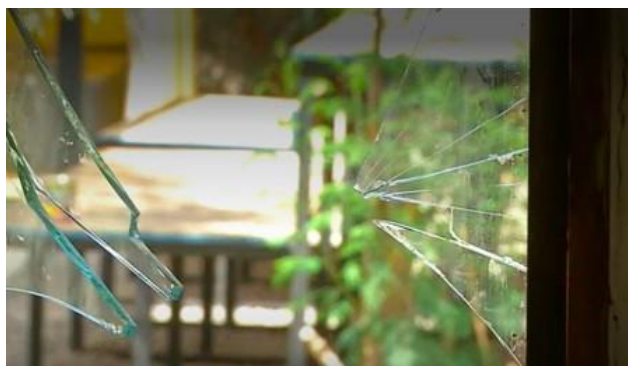
Robo y destrozos en la Casa de la Memoria Copiapó. Fuente: 24 horas (21 de enero de 2020).
